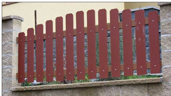
Plot je možné realizovať aj v murovaných stĺpikoch
